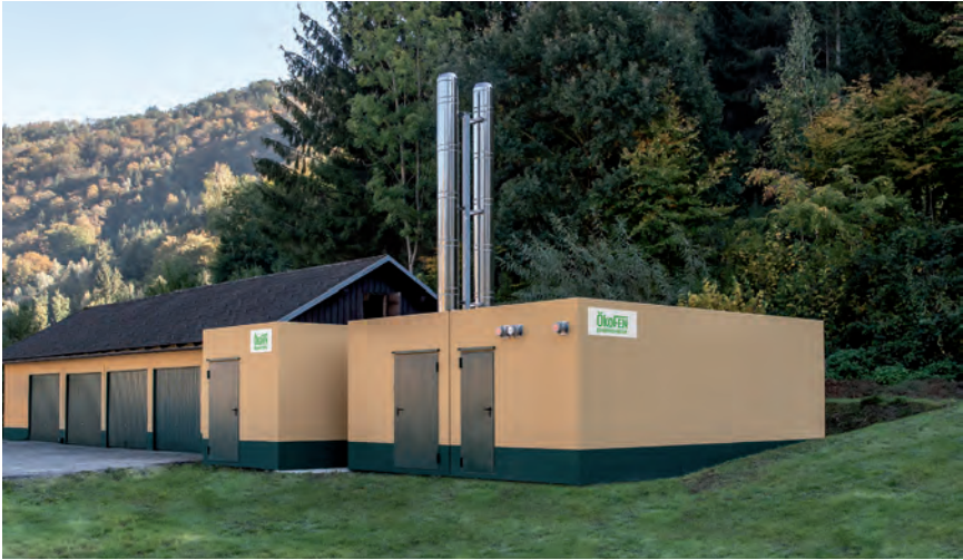
Umstellung auf eine große 400-kW-Pelletsheisanlage
