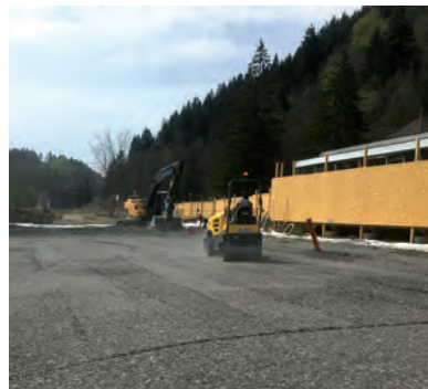
Aufbringen des Schüttgutes
